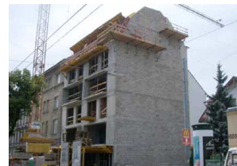
strassenfassade in bau
